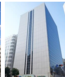
肥後橋センタービル (大阪府大阪市)
