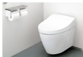
トイレのリニューアル工事
