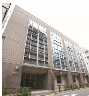
湯島ファーストジェネシスビル
