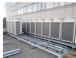
空調設備の更新
