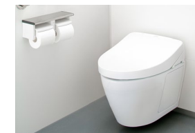
トイレのリニューアル工事
